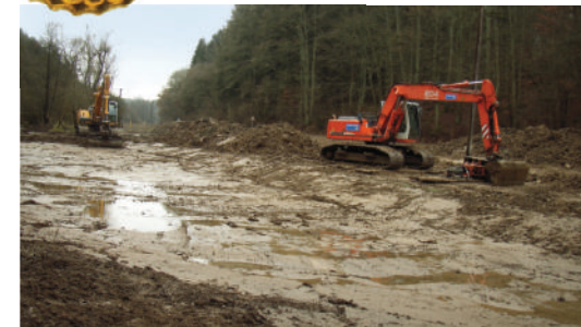
„Naturschutz-Bagger“ im Einsatz. Künstliche Wiederherstellung natürlicher Auestrukturen.
