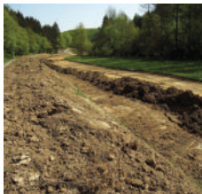
Komplette Räumung eines 29 m breiten Arbeitsstreifens im Rahmen der Leitungsverlegung 2007.
