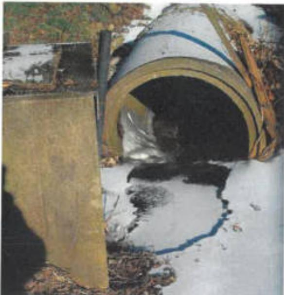
Bild 2: Betonrohr am Mönch mit Sohlenabsturz (Foto: L. Germer)
